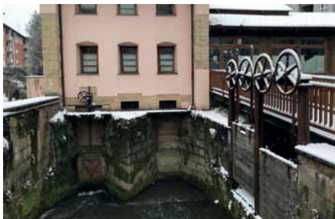
Infraestructuras de la Fandería.
