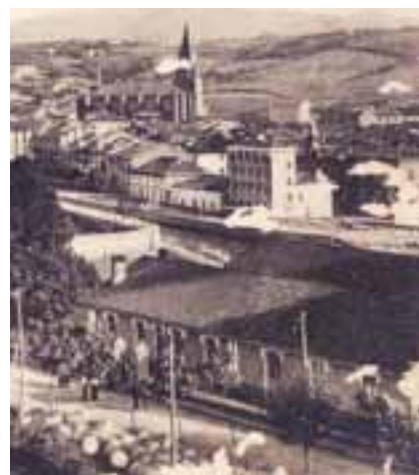
Detalle de los toneles almacenados frente a la fábrica de Productos Tártricos. EUA-AME A013 F043.
