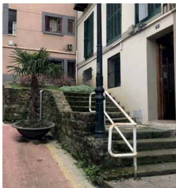
Escaleras de acceso al puente de entrada a la Fabril Ibero-Belga.
