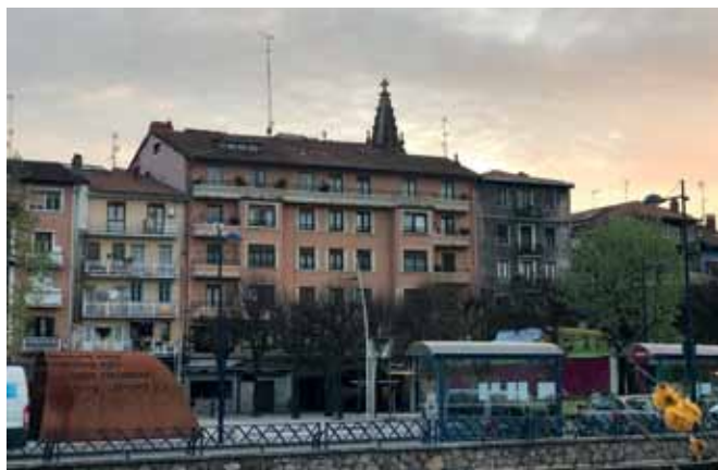
Edificio Alameda de Gamón 14, antigua fábrica S. Echeverría Tejidos de Lino.
