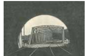
Trenbidea eta zubia bikoizteko lanak eta zabaldu ondorengo Kaputxinoetako tunela eta burdinazko zubi berria.
