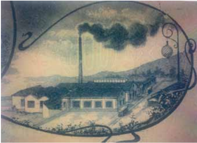
Cocheras de Ategorrieta, con máquina de vapor para la generación de electricidad.
