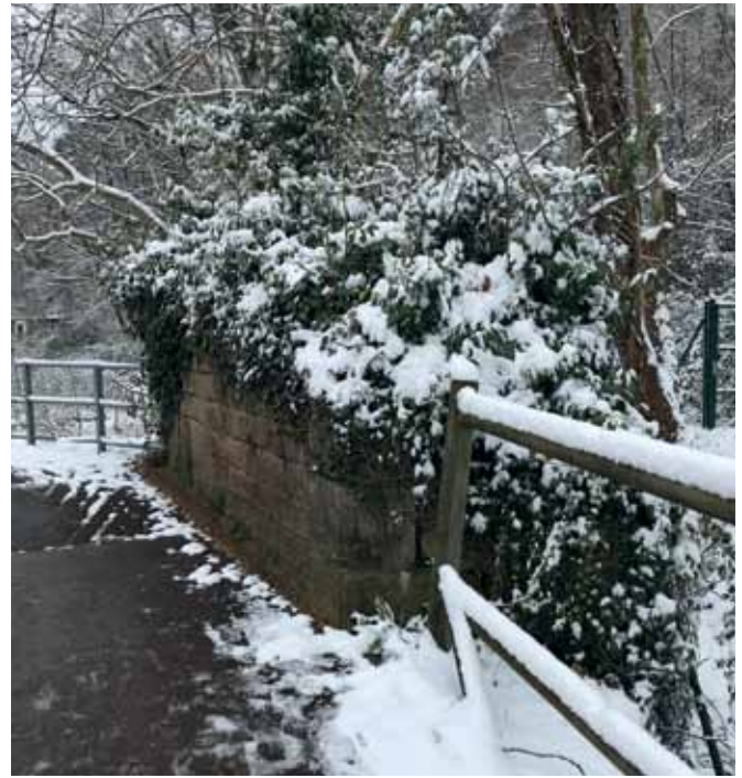
Base del puente peli actualmente.
