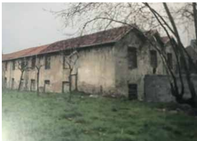
Pabellones de la Fábrica de Lino Gamón Hermanos, en el interior de la Fabril Lanera.
