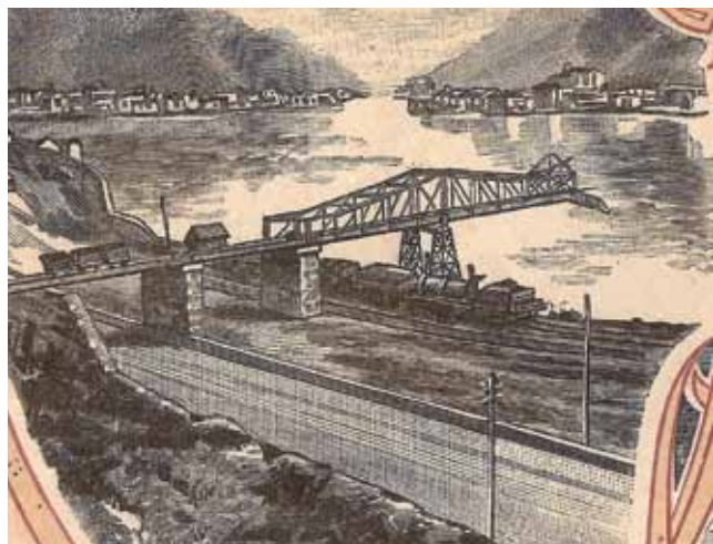
Detalle del cargadero Cantilever.
